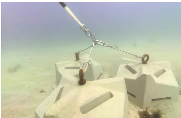
砂礫地に設置したコンブ林コンクリート基盤
