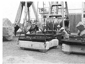
海流に流されないよう、コンクリートと組み合わせます
