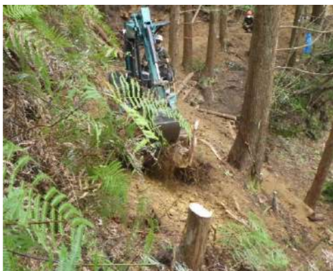
切株を掘り起こして除去
