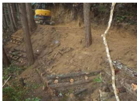
木組みで土砂を止め
