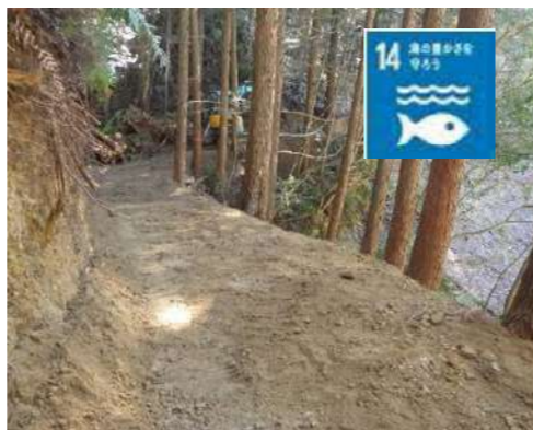
何もなかった山に作業道開設
